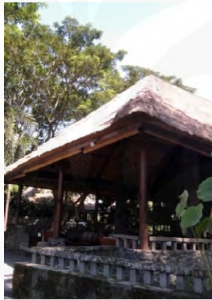
Gambar 4.13. Penerapan kaidah kejelasan struktur dan kejujuran material pada atap dan kolom-kolom lobby (Sumber : dokumentasi pribadi)
