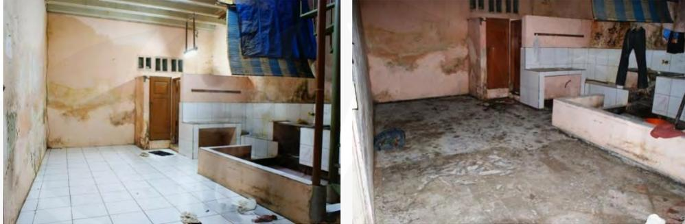
**Gambar 3.49 Lapisan Lantai Keramik Rumah Utara Bagian Dalam Sebelum dan Setelah Diangkat**
