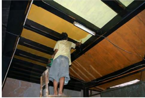
**Gambar 3.63 Proses Pengecatan Ulang Pada Plafond Lantai Atas Rumah Utara**
