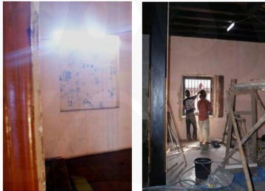
**Gambar 3.58 Dinding Belakang Lantai Atas Rumah Utara Sebelum dan Setelah Ditambahkan Jendela Yang Disesuaikan**
