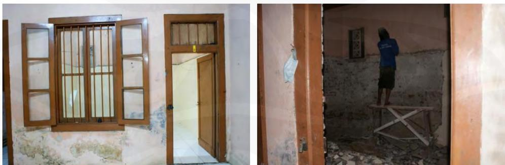
**Gambar 3.51 Lapisan Lantai dan Dinding Keramik Kamar Bawah Rumah Utara Sebelum dan Setelah Diangkat**
