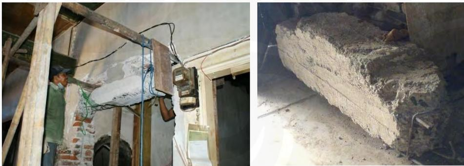
**Gambar 3.56 Pembongkaran Balok Lengkung Pada Tempat Jendela**
