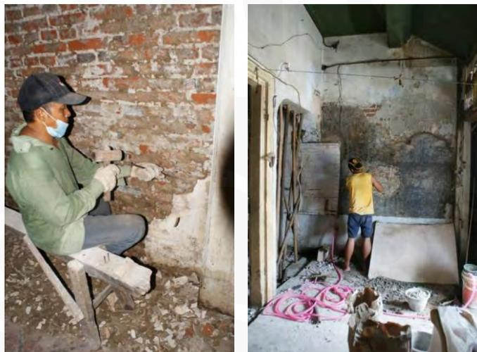
**Gambar 3.54 Pengupasan Bagian Plaster Yang Rusak Pada Dinding**
