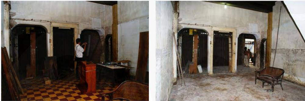
**Gambar 3.50 Lapisan Lantai Keramik Rumah Utara Bagian Depan Sebelum dan Setelah Diangkat**
