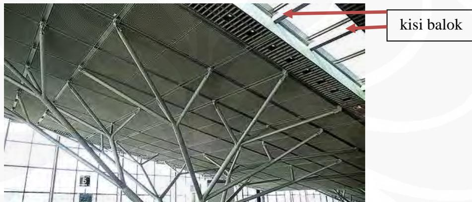
**Gambar 4.6.** Satu struktur pohon baja menopang satu atap tunggal
