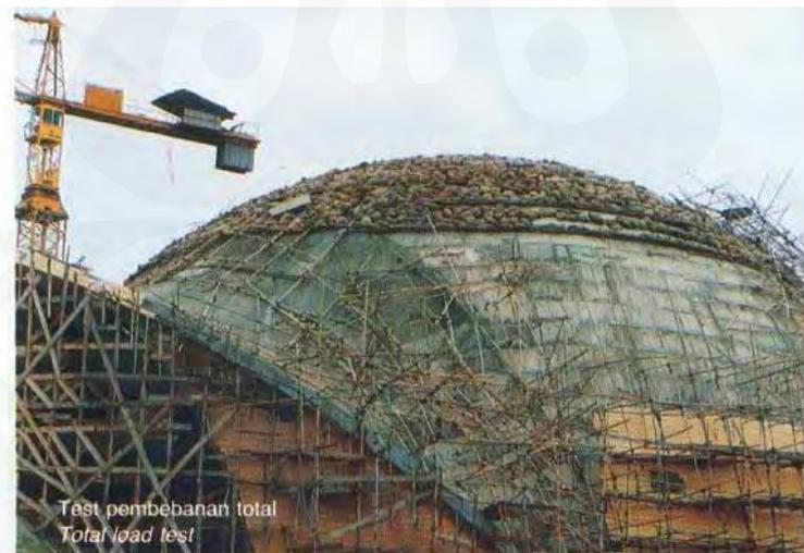
**Gambar 4.22.** Tes pembebanan pada bangunan Keong Mas TMII
