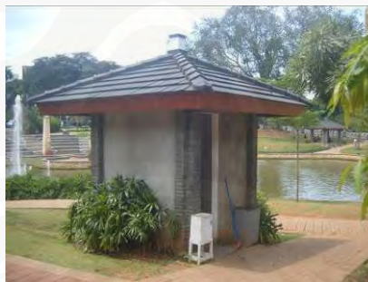
Gambar 3.69 Toilet Umum di Taman Ayodia Sumber: dokumen pribadi
