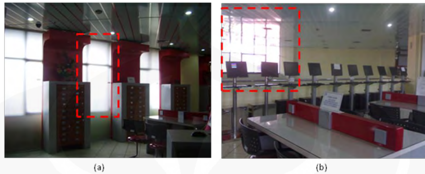
Gambar 4.7. Filter pada Bukaan Samping Area Digital Catalog ; (a) Kaca Susu dan (b) Kaca Riben Sumber : Dok. Pribadi
