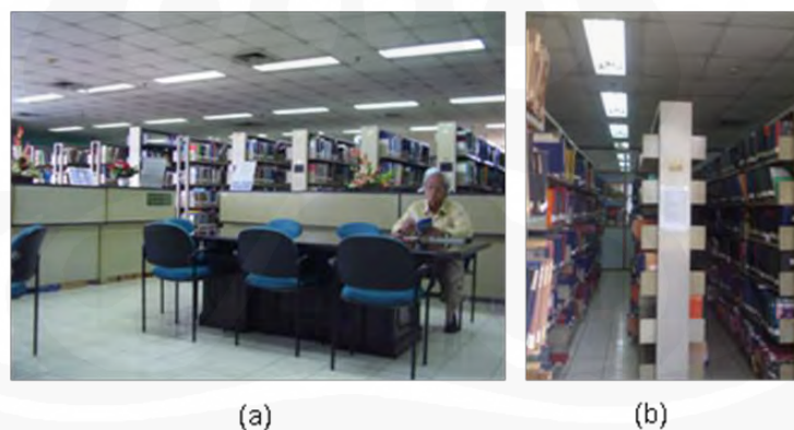
Gambar 4.9. Pencahayaan Buatan pada Perpunas : (a) Perpendicular Scheme dan (b) Parallel Scheme
