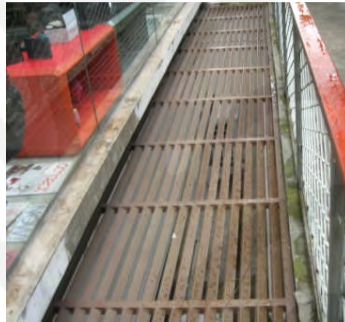
Gambar 3.43 Pencahayaan alami menuju Basement (Sumber: Dok. Pribadi)
