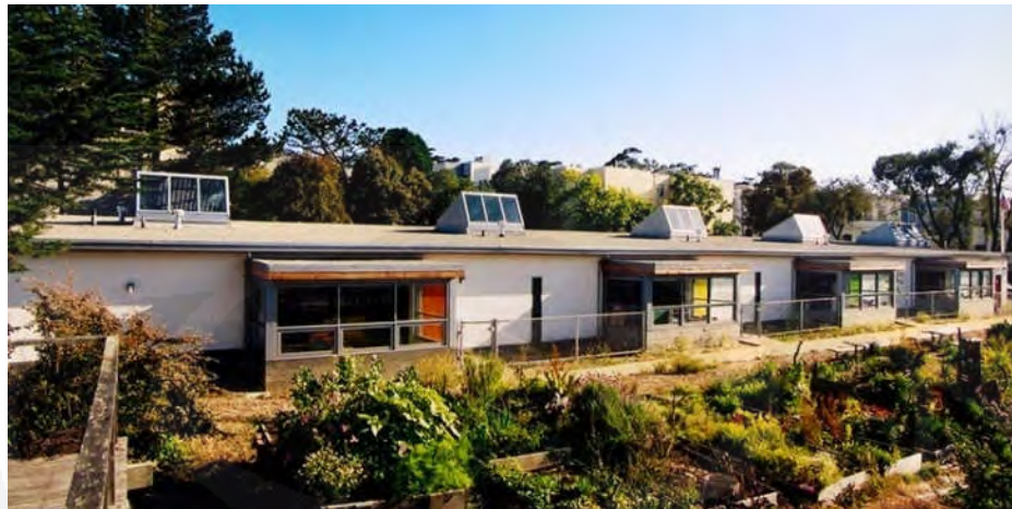
Gambar 3.60 Kondisi halaman belakang sekolah yang dialihfungsikan sebagai lahan berkebun (Sumber: 450architects.com)
