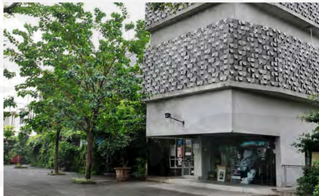
Gambar 3.27 Tampak depan kompleks Komunitas Salihara (Sumber: Salihara.org, 2010)
