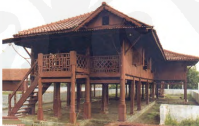
Gambar 3.56 Kondisi Rumah Si Pitung sebelum renovasi (Sumber: Jakarta.go.id)
