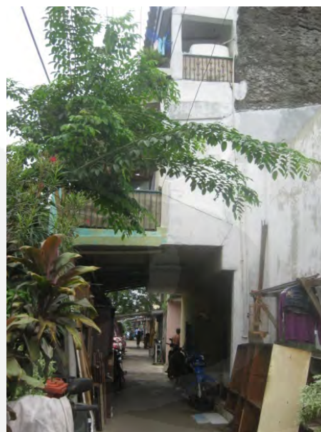
Gambar 19. Perluasan lantai atas rumah yang berfungsi sekaligus sebagai naungan
