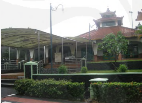
Gambar 47. Masjid RW 27 Pesona Khayangan Estat
