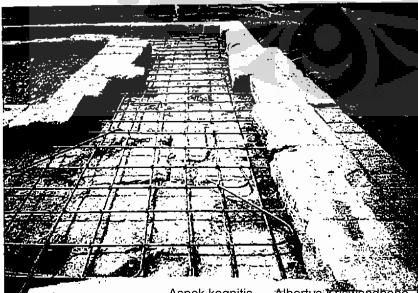
Foto 18: Wiremesh (jaring kawat), keadaan sebelum pengecoran. Anyaman besi berfungsi sebagai penahan gaya tarik pada saat terbebani, sedangkan beton berfungsi penahan gaya tekan pada saat terbebani.
