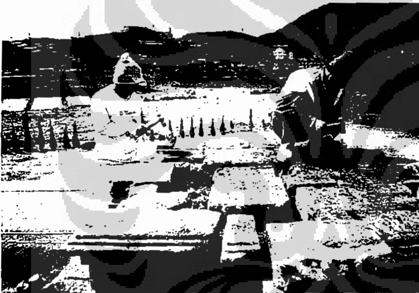
Foto 2: Kondisi batu pada atap candi saat dilakukan restorasi. Para tukang menggunakan alat tatah batu ( iw:betel ) untuk memberikan kode batu dan melepaskan masing-masing bilah batu karena kondisinya telah lengket karena faktor alam, seperti kotoran tanah, lumut, jamur.
