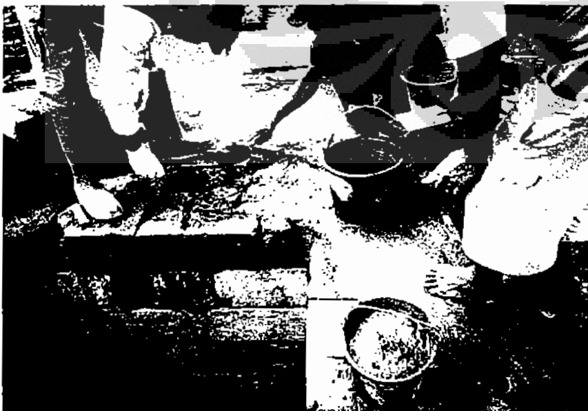
Foto 27: Proses pembuatan struktur tambahan berupa ring balk beton bertulang, terletak melingkari candi, persis pada ketinggian di atas pintu candi.
