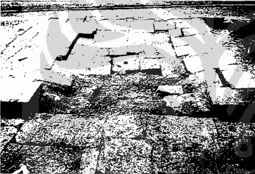
Foto 11: Batu pengisi di bawah lantai bilik candi terlihat melesak ke bawah. Penurunan struktur akibat penurunan tanah.
