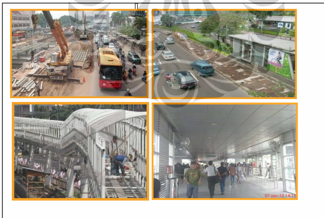
Gambar 5.1. Pembangunan Koridor BRT-Transjakarta
