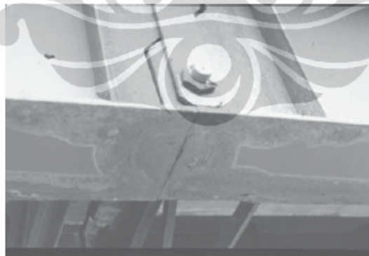
Gambar 2.3. Korosi Ringan Pada Jembatan Baja Paduan Ketika Proteksi Lapisan Luar Telah Hilang. (Jenkins, 2005)
