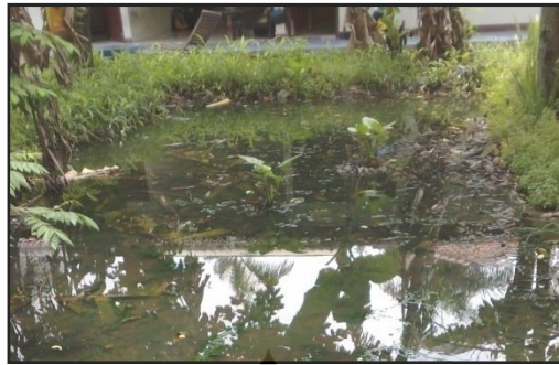
Gambar 3.9: Kolam penampungan akhir limbah.
