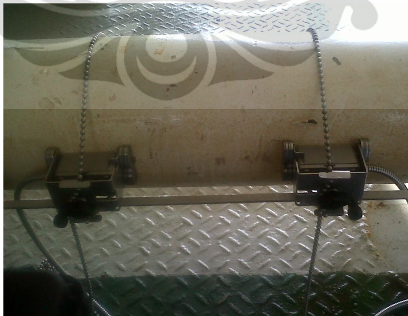
Gambar 3.9. Posisi Pemasangan Transducer
