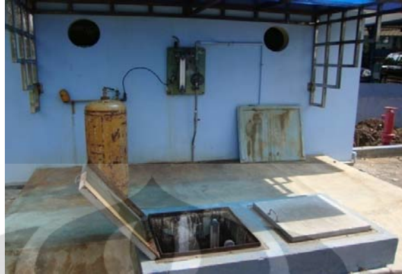
Gambar 5.11. Bak Disinfektan
