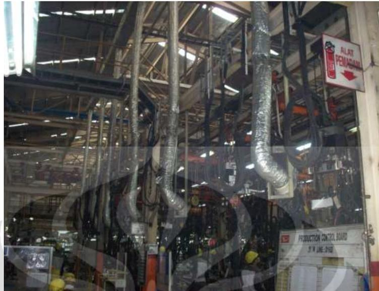
**Gambar 4.1** Gambar Pemasangan AC dengan *Ducting* Mengarah ke Operator
