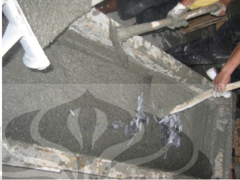
Gambar 3.9 Proses mencampur steel fiber dengan beton segar
