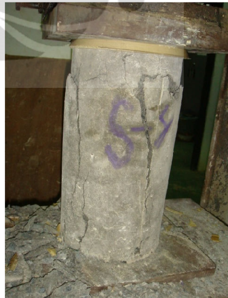
Gambar 4.3 – Retak pada sampel Uji Tekan
