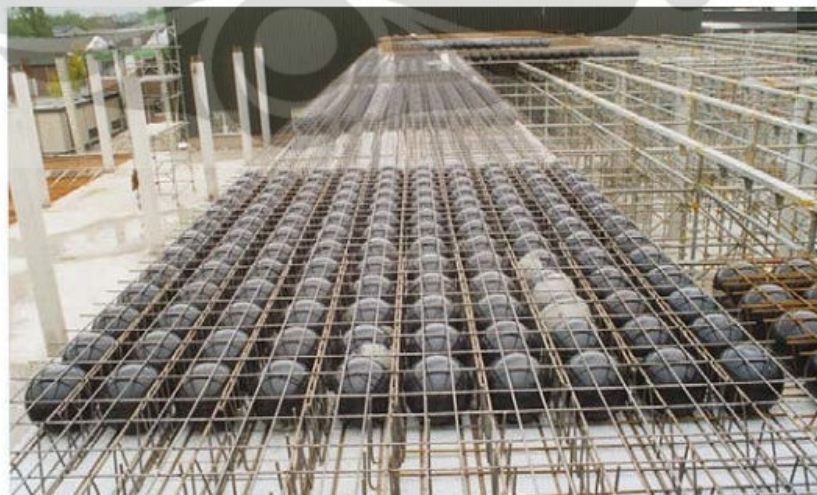
Gsmbar 2.11 Penempatan Elemen Bubble Deck
