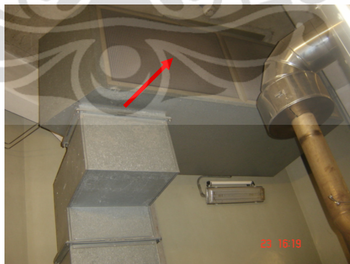
Gambar 3.6 Extract plenum box atas
