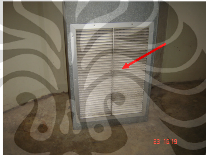
Gambar 3.5 Extract plenum box bawah
