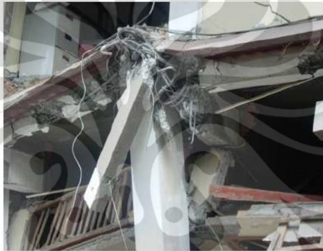
Gambar 2.13 Contoh Kerusakan Bangunan Pada Sambungan Balok Kolom
