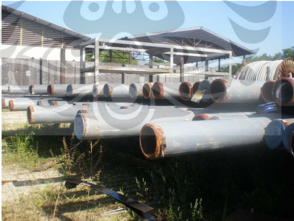
(b) Kondisi pipa yang disimpan sebagian besar tanpa penutup
