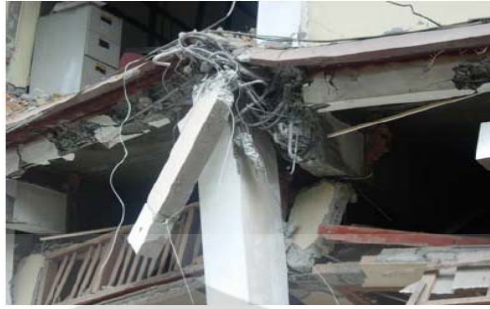
Gambar 2.10. Contoh Kerusakan Bangunan Pada Sambungan Balok dan Kolom
