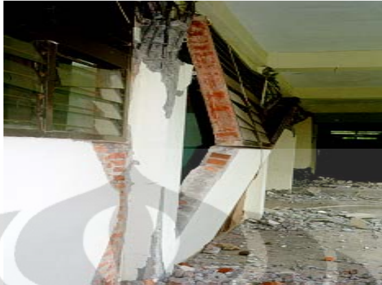
Gambar 2.6. Keruntuhan Dinding di Bengkulu
