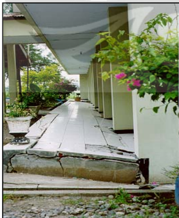
Gambar 2.7. Akibat penurunan level bangunan di Bengkulu dan Banda Aceh
