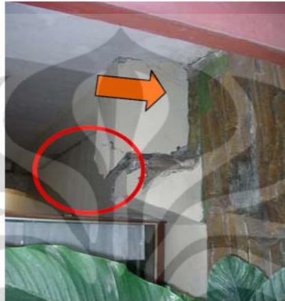
Gambar 2.8. Contoh Kerusakan Bangunan Akibat Geser pada Balok Konsol
