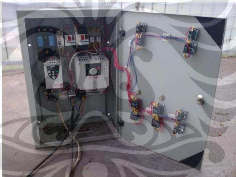
Gambar 3.8 *Control panel* yang digunakan untuk feeder dan blower
