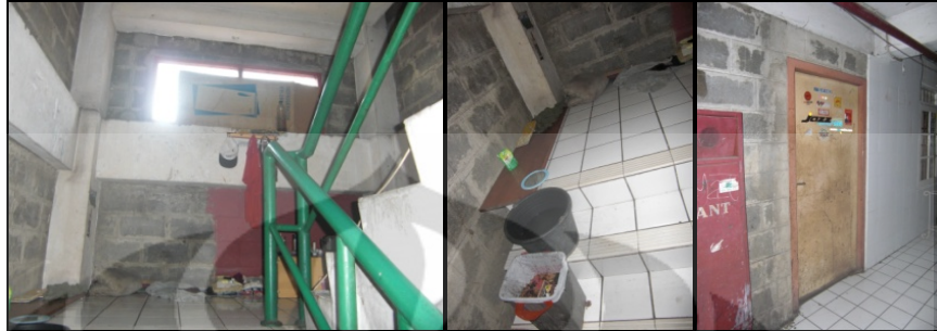
Gambar 3.13. Tangga Darurat Sumber: Dokumentasi Pribadi
