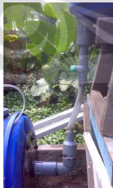
Gambar 3.3 Sistem perpipaan saluran masuk slurry
