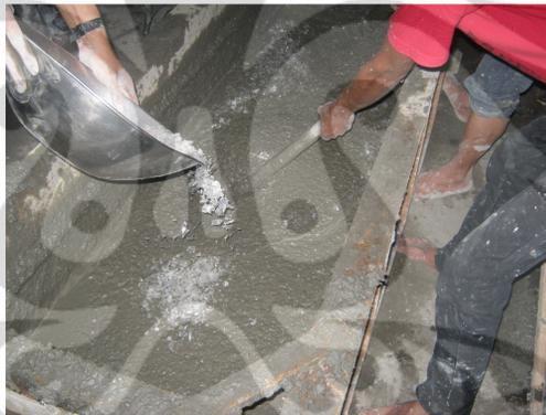
**Gambar 3.6** Penambahan PET dalam Campuran Beton
