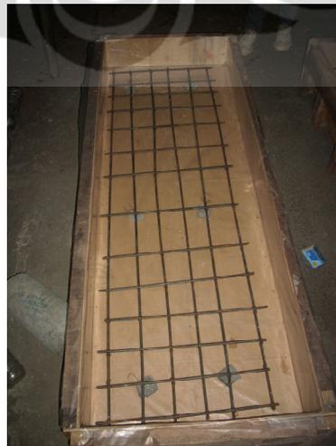
**Gambar 3.4** Pemasangan Tulangan Lentur dan Beton *Decking*
