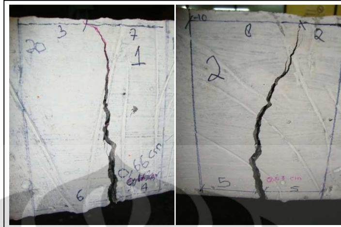
Gambar 4.29 Gambar foto Retak Pelat beton (SF 0,19-1-B)
