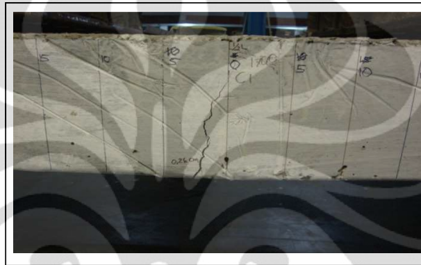
Gambar 4.27 Gambar Foto Retak pelat beton (SF 0,19-1-A)
