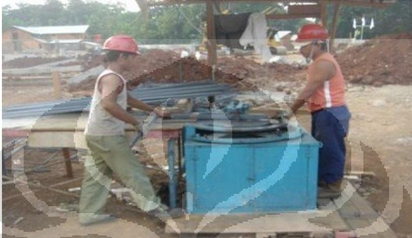
**Gambar 5.12** Pekerjaan Pembesian Di Area Pabrikasi Besi
