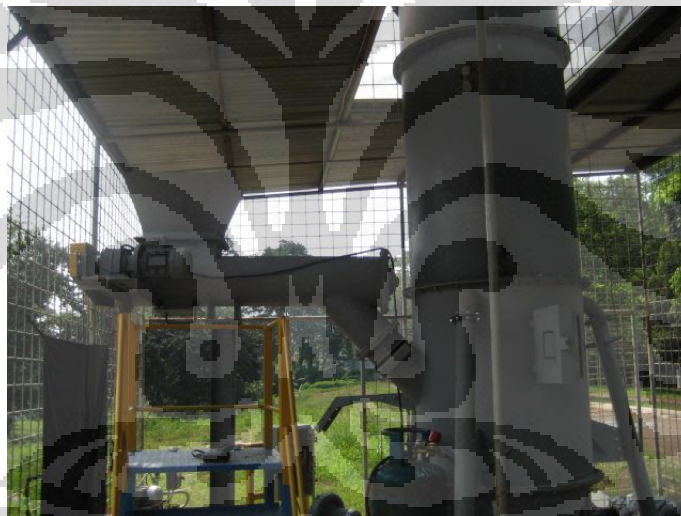
Gambar 3.10 Screw Feeding yang sudah terpasang
