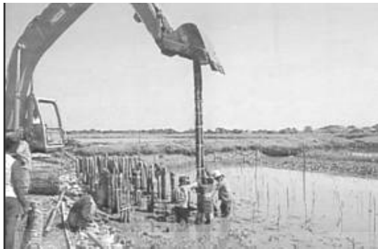
(a) Pemasangan Cerucuk Bambu
