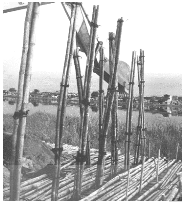
(a) Pemasangan cerucuk bambu
