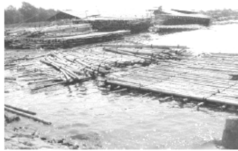
(b) Pemasangan matras bambu
