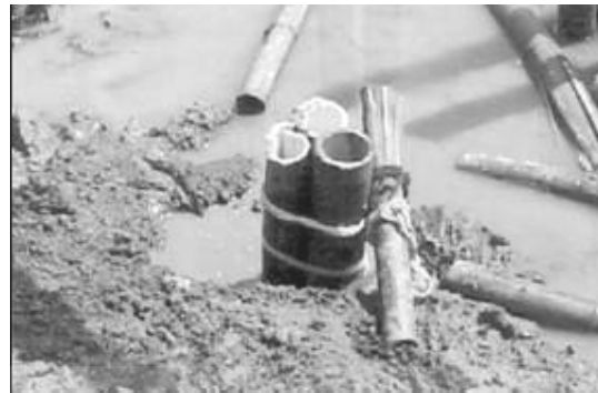
(b) Ikatan 3 Bambu untuk Struktur Cerucuk
