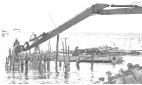
(a) Pemasangan cerucuk bambu
