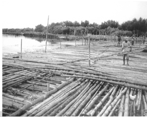
(b) Pemasangan matras bambu
