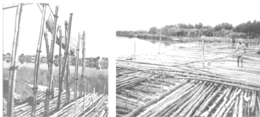
(a) Pemasangan cerucuk bambu
