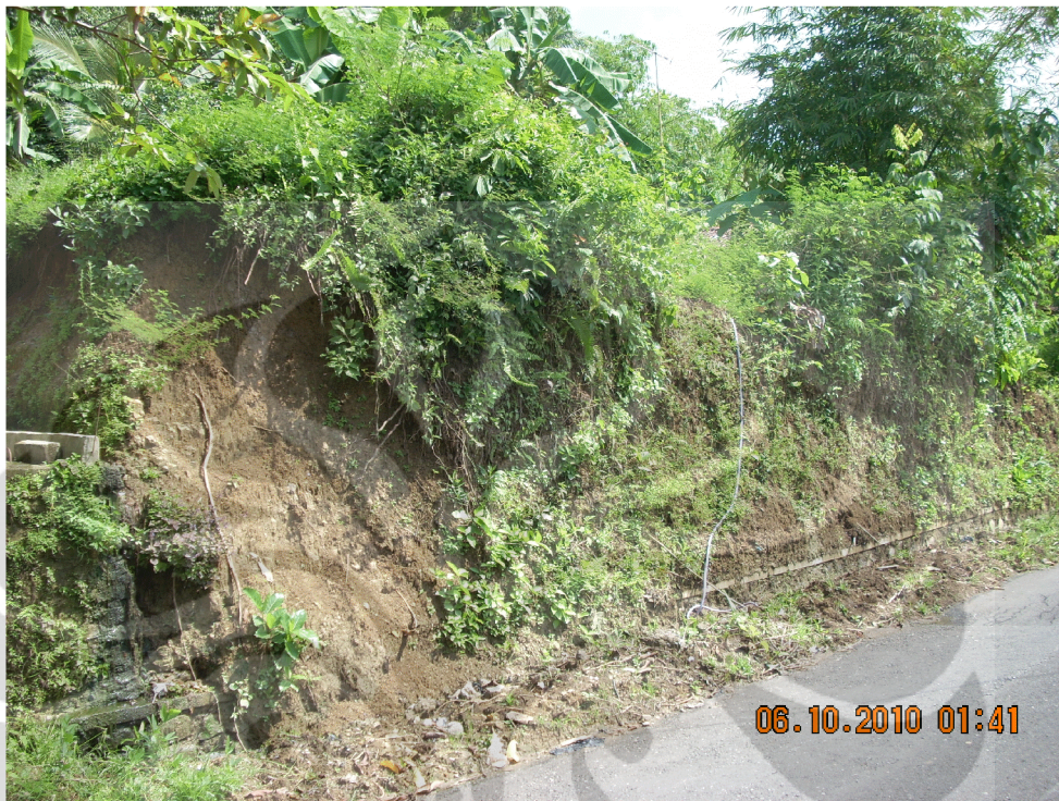
Foto 1. Longsor di Kampung Karangdadi, Desa Bojongsari, Kecamatan Alian, Kabupaten Kebumen
