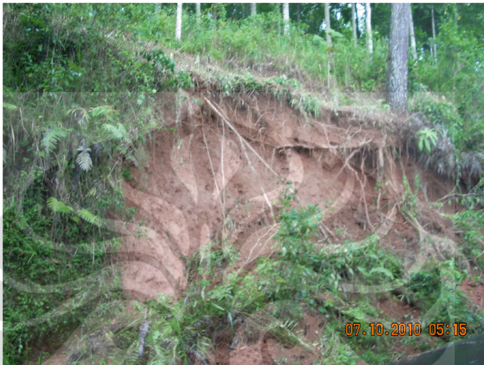
Foto 5. Longsor di Kampung Pesawahan, Desa Plumbon, Kecamatan Sadang, Kabupaten Kebumen
