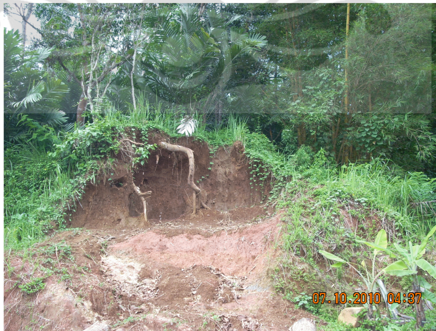
Foto 2. Longsor di Kampung Depok, Desa Gunungjati, Kecamatan Banjarnegara, Kabupaten Banjarnegara
