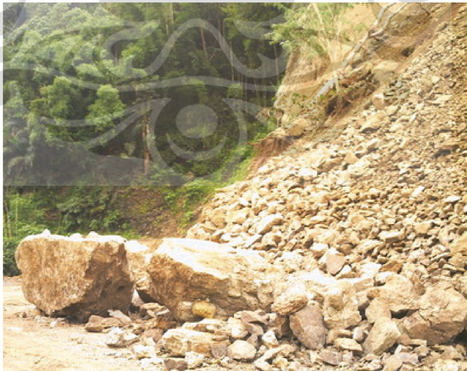
Foto 14. Lereng Rombakan (M2)
