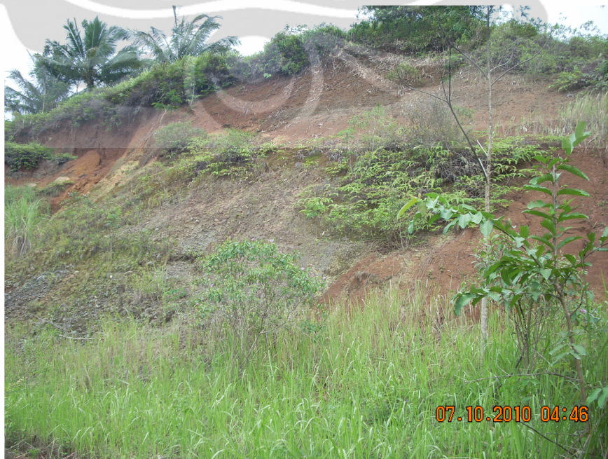
Foto 4. Longsor di Kampung Ponjen, Desa Pagedongan, Kecamatan Banjarnegara, Kabupaten Banjarnegara
