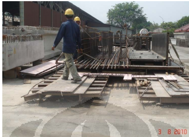
Gambar 4.8 Proses Pemesian Beton Pracetak (Sumber: ekskursi sipil UI tahun 2011 )
