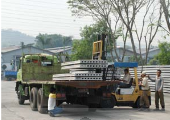
Gambar 4.9 Proses Pengangkutan Beton Pracetak Ke Kendaraan Pengangkut
