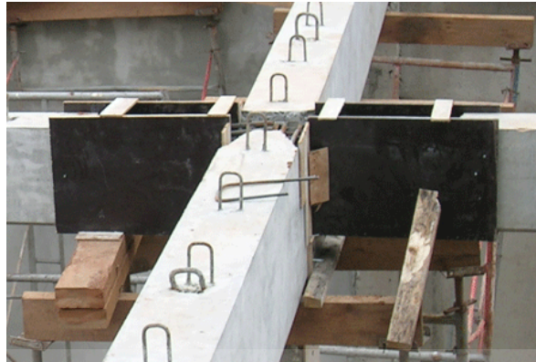
Gambar 4.11 Sambungan Pada Balok dan Kolom Precast
