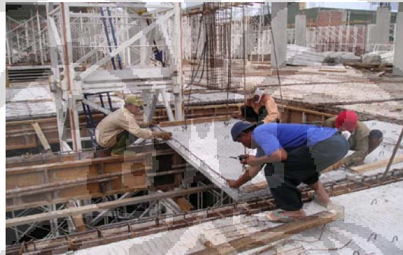
Gambar 4.10 Proses Pemasangan Pelat Precast
