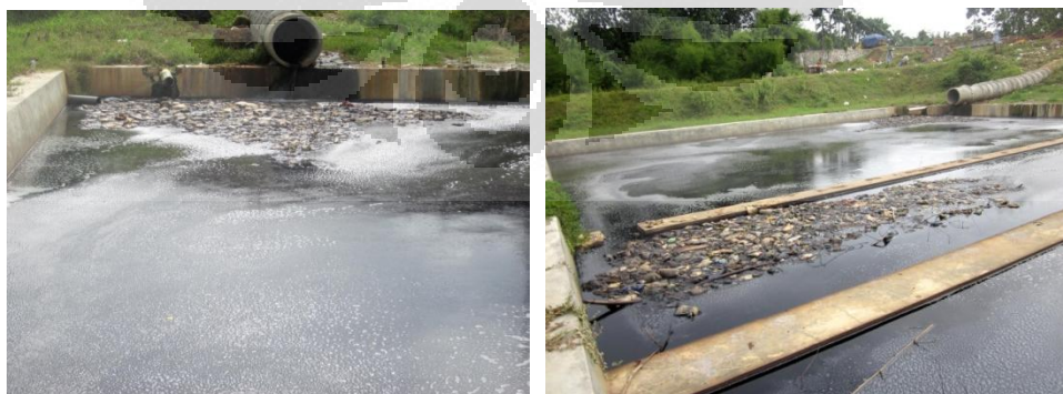
Gambar 4.6. Instalasi Pengolahan Lindi 2 TPA Cipayung (Observasi Penulis, 2011)
