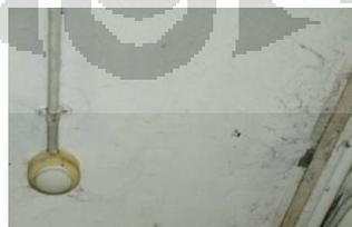
Gambar 3.43. *Heat detector* di koridor
