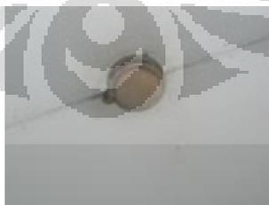
Gambar 3.27. *Heat detector* yang terdapat di koridor
