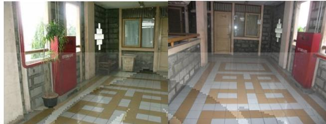
Gambar 3.44. *Hydrant* yang terletak di ujung koridor
