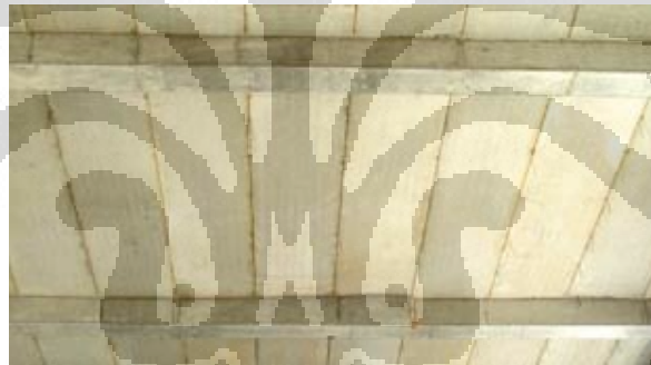
Gambar 1.2. Sambungan antar pelat pracetak 5
