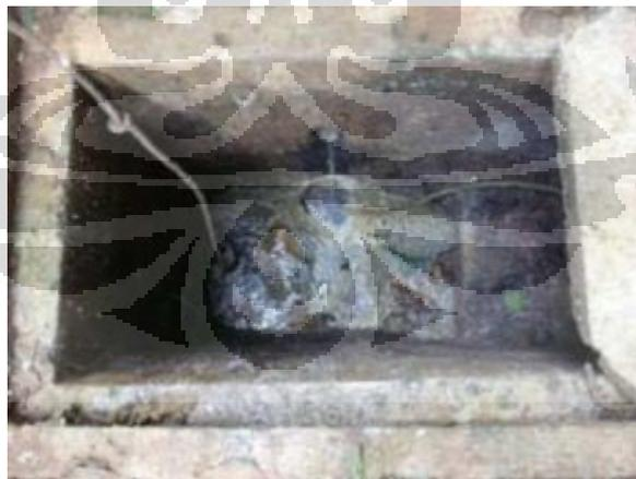
Gambar 4.4. Bak Penangkap Lemak Kantin Yongma FISIP UI
