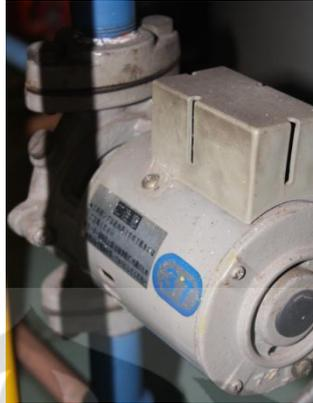
Gambar 3.11. Pompa kondensat
