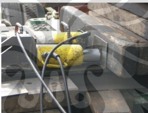
Gambar 3.4 Jacking sistem
