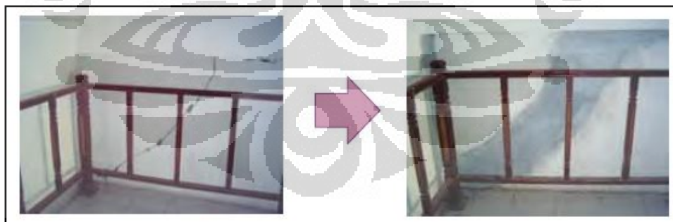
Gambar 1. 7. Metode Perbaikan Plester dan Kawat Anyam Terpaku (3) (Sumber: Boen, Teddy and associates, 2010)
