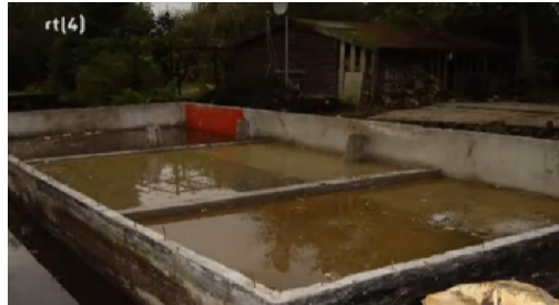
Gambar 3.14 Struktur Bawah (pontoon) Watervilla (sumber : www.youtube.com )
