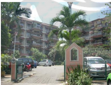
Gambar 3. 1. Kondisi Umum RUSUNA Harum Tebet Barat Sumber : dok.pribadi
