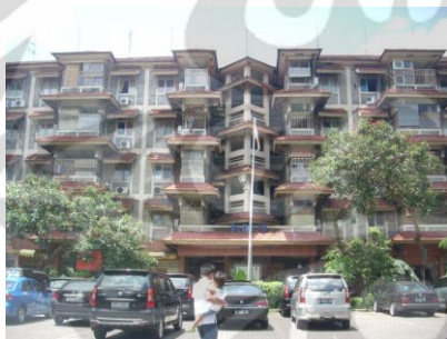
Gambar 3.3 Kondisi RUSUNA yang bersih dan indah. Jarang yang menjemur pakaian sembarangan. Sumber : dok.pribadi
