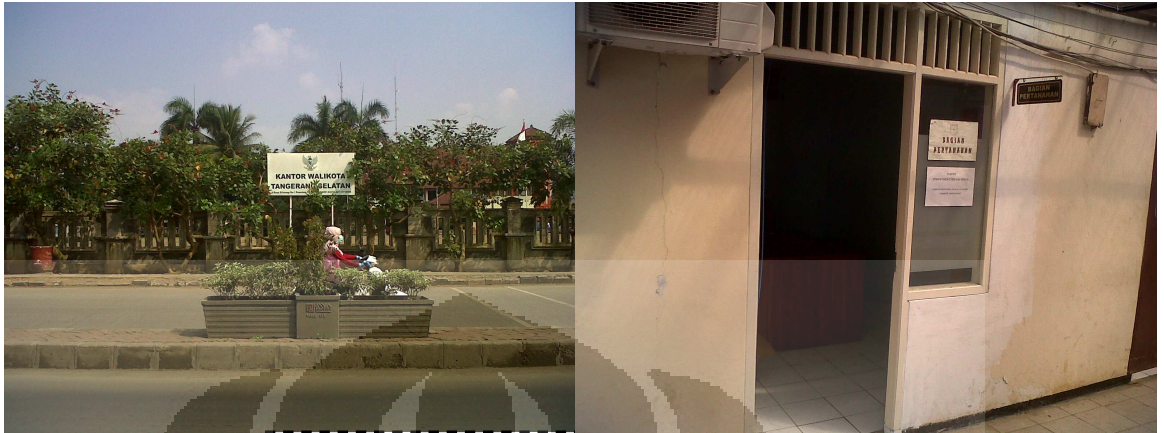
Gambar 5.4 Kantor Walikota Tangsel yang masih menumpang dengan kantor Kec. Pamulang (kiri) dan salah satu gedung Sekda Tangsel tampak rusak
