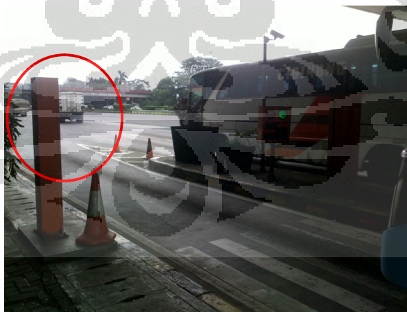
Gambar 4.7 Sensor Tiang yang Terdapat Pada Tiap Lajur Gardu
