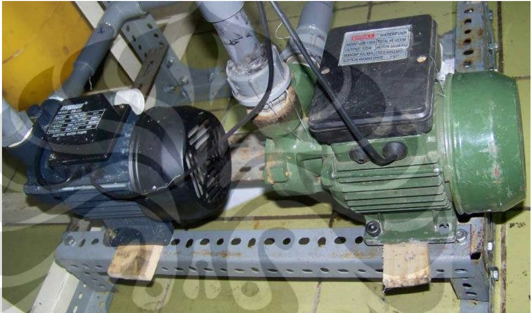
Gambar 3.4 Pompa sentrifugal
