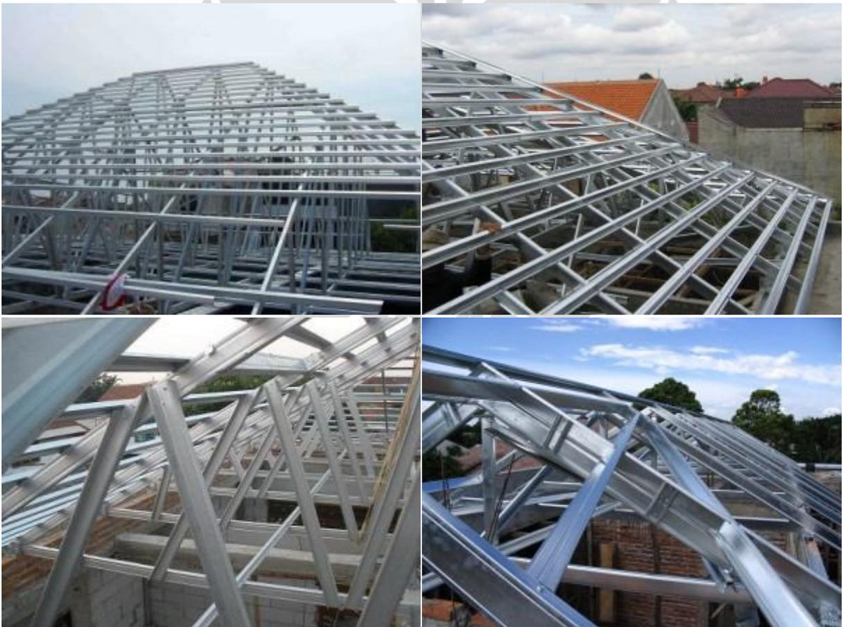
Gambar 2.1 Konstruksi rangka atap baja ringan
