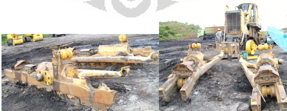
Gambar 31. Pengerjaan overhoule diluar work shop
