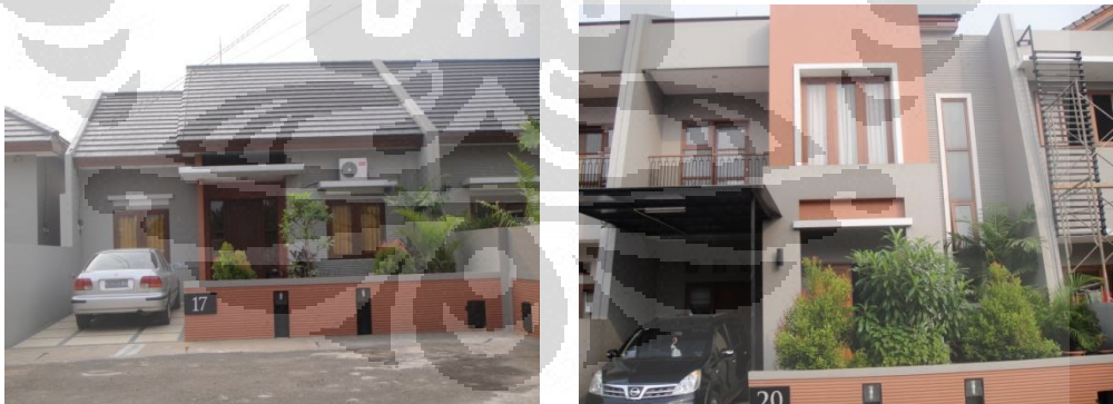
Gambar 4. 4 unit 1 lantai Villas Tropic (kiri) dan unit 2 lantai Villas Tropic (kanan)
