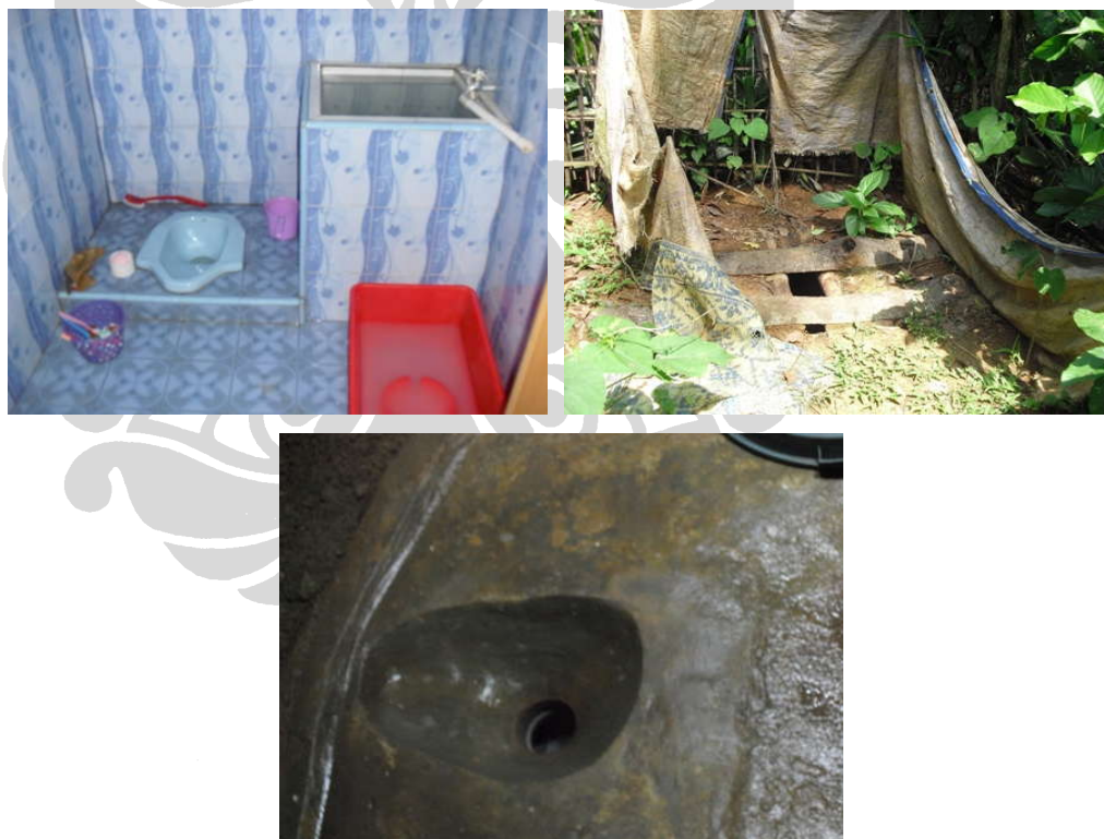
Gambar 3.9 : Cubluk Sederhana (kanan atas), Jamban Permanen Yaitu Jamban Leher Angsa (kiri atas) dan Jamban yang Menggunakan Paralon yang Disambungkan ke Sepictank (bawah)
