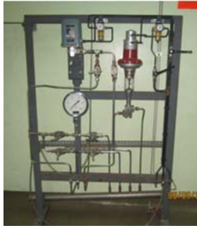
Gambar 2.3. Sistem pneumatic tungku Autoclave
