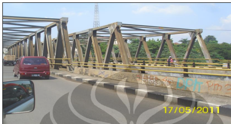
Foto 4.1 : Jembatan di jalan Baru Ir. H. Juanda Depok
