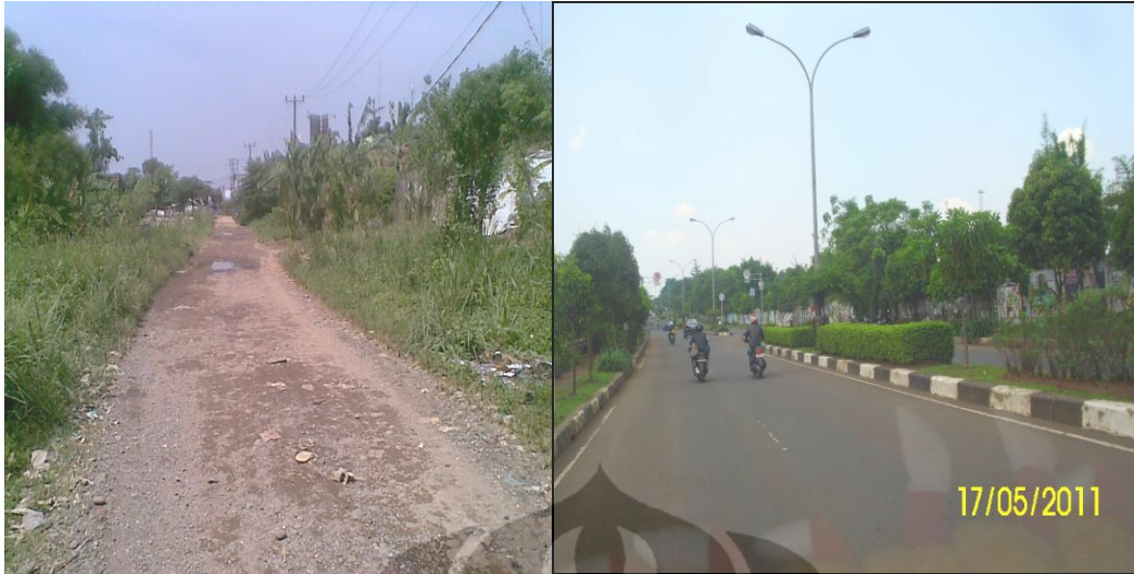
Foto 4.2. Kondisi sebelum jalan baru
