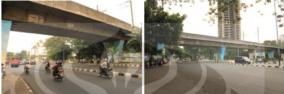
Gambar 4.12 Jembatan Rel Kereta Sebagai Naungan
