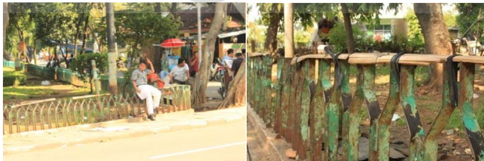
Gambar 4.22 Modifikasi Pada Pagar Dengan Menggunakan Bambu
