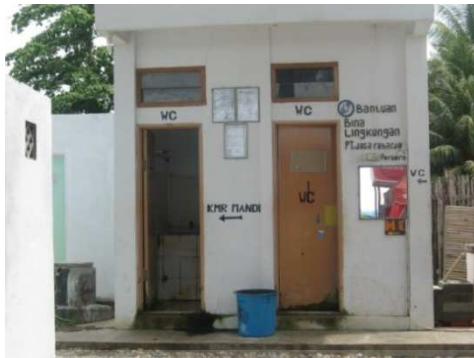
Kondisi kamar mandi dan kamar ganti pantai
